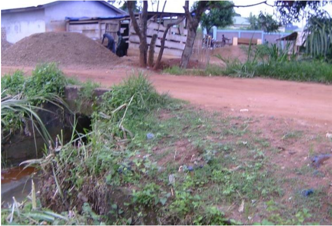
Site de MOHOMOU avant la construction du dalot
