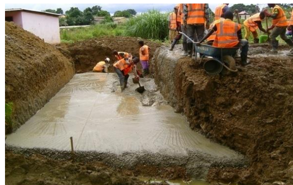
Béton de propreté à Mohomou
