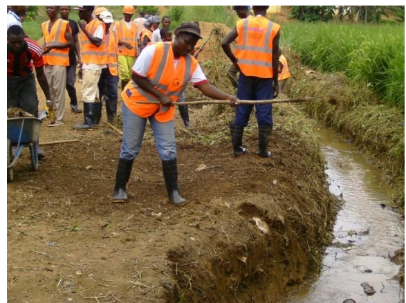
Curage du lit des cours d'eau
