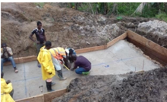
Béton de propreté à Gonia III
