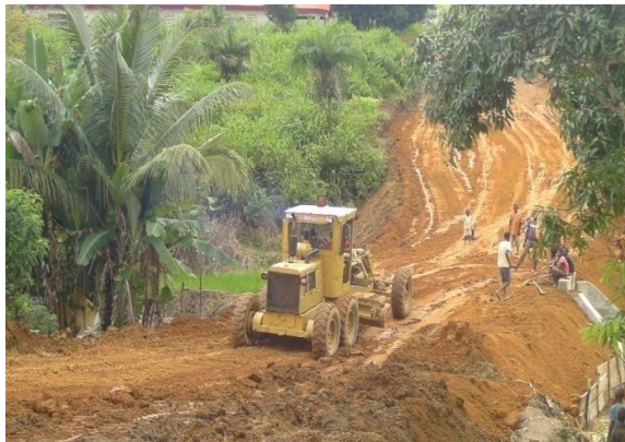
Remblai, Nivelage et compactage par la méthode HIEQ (haute intensité des équipements)
