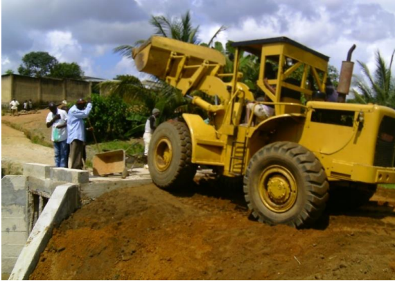
Remblai, Nivelage et compactage par la méthode HIEQ (haute intensité des équipements)
