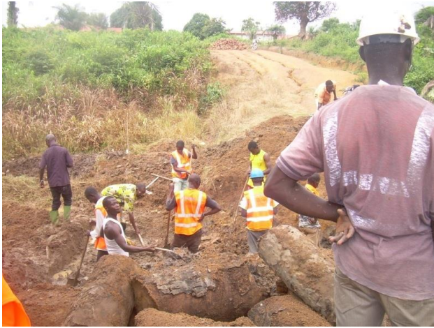
Site de GONIA III avant la construction du Dalot (un pont en troc de palmiers)
